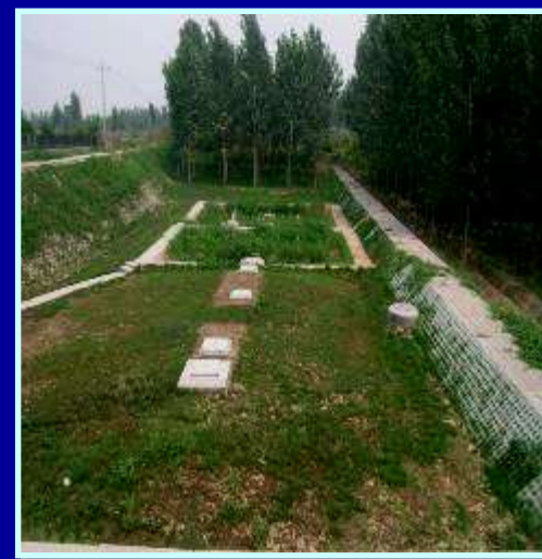
房山西地村湿地污水处理
