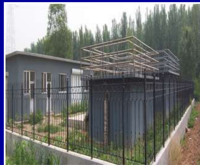
昌平酸枣岭污水处理站
