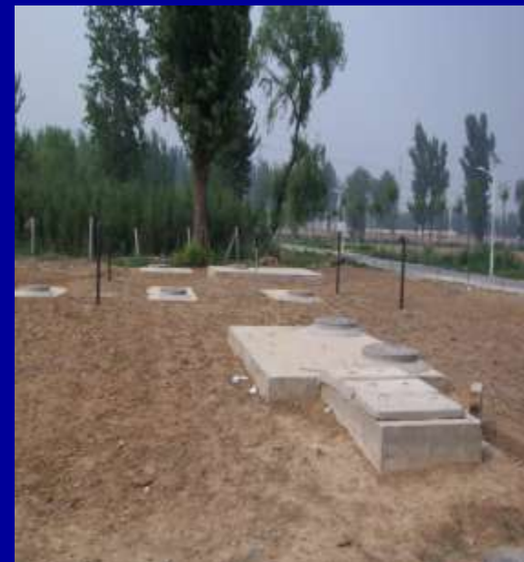
昌平东贯市村污水处理站
