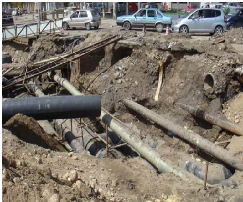
2012年，呼和浩特某十字路口地下管线
