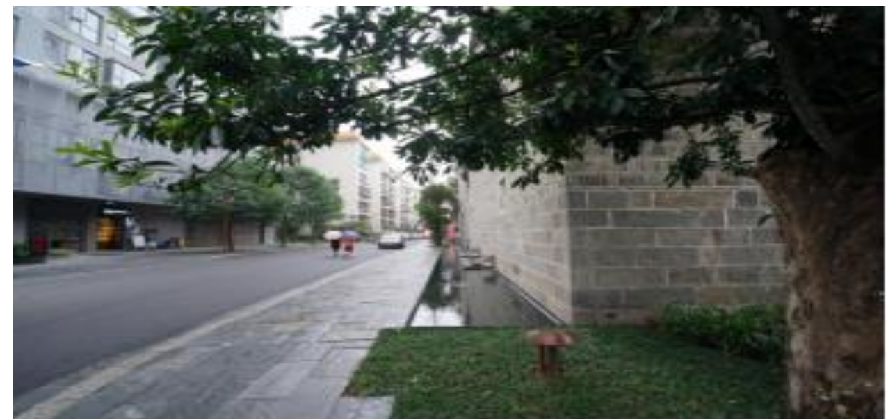
房屋墙角雨水收集沟
