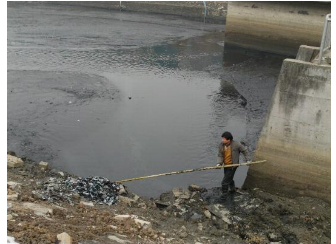
泵站调蓄池原貌
