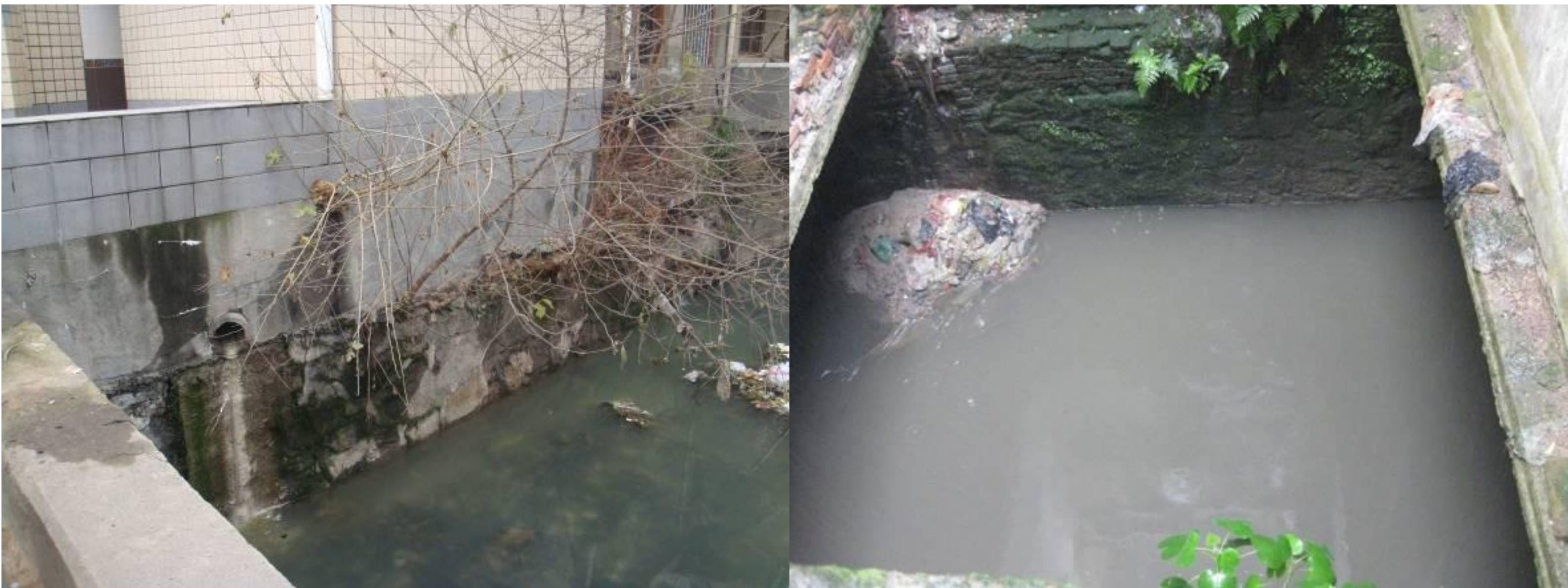
典型的护城河沿线直排口现状照片
